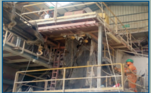
MANTENIMIENTO DE CHANCADORA HP 500 METSO
