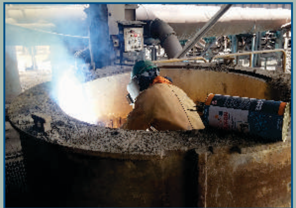
REPARACIÓN DE GRIZZLY VIBRATORIO METSO
