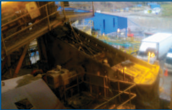
CAMBIO DE FALDONES DE TOLVA DE FINOS - PARADA DE PLANTA
