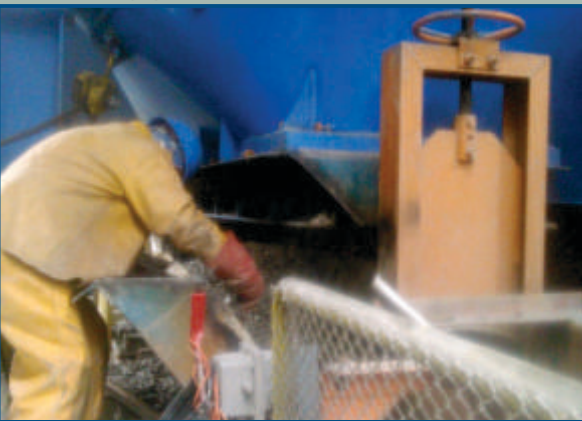
REPARACIÓN DE CELDAS DE FLOTACIÓN
